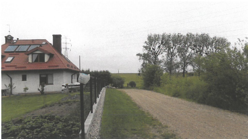
Zbliżenie linii 110 kV do budynku nr 37 w miejscowości Olecko Kolonia (P.P.2)
