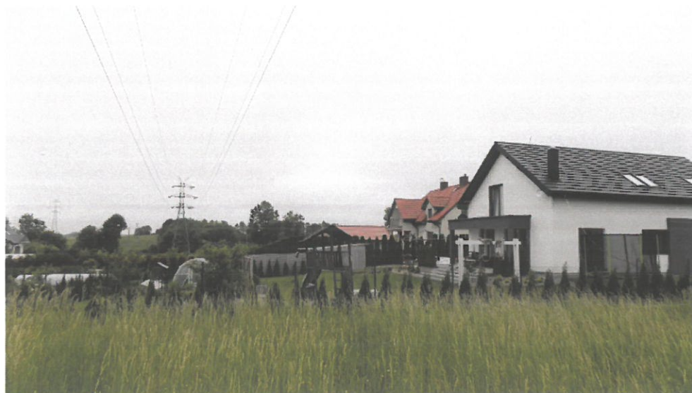
Zbliżenie linii 110 kV do budynku nr 28 z tarasem od strony linii w miejscowości Olecko Kolonia (P.P.3) i (P.O.1). W oddali kolejny budynek mieszkalny (P.P.4)
