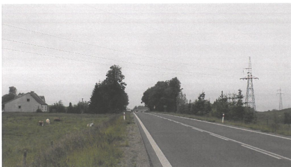
Linia 110 kV nad drogą krajową DK65
