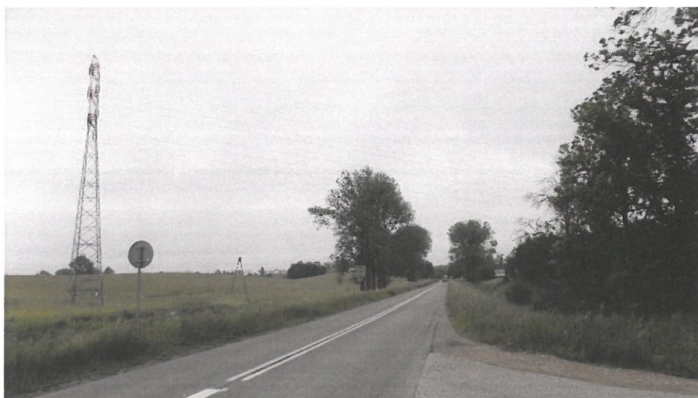
Linia 110 kV nad drogą nr 655 miejscowości Olecko Kolonia (P.P.1)
